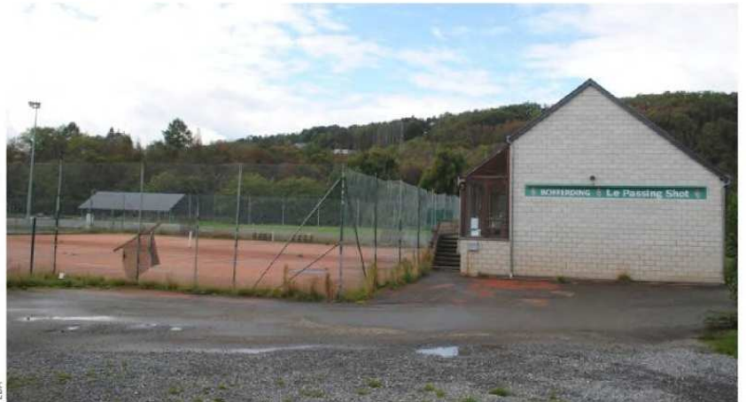
Le futur skatepark de Barvaux prendra place sur le site du Juliéna, en lieu et place des terrains de tennis extérieurs.
