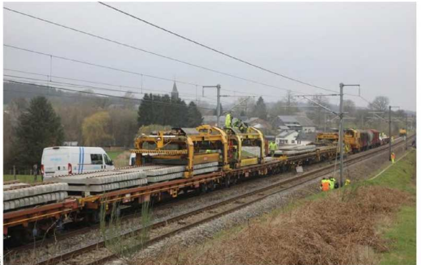
En une semaine à peine, la machine a remplacé 24 000 traverses en béton entre la gare de Gedinne et celle de Paliseul sur une distance de 14 km.
