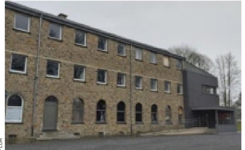
Le projet de maison de repos « Vulpia » est prévu dans le parc situé à l'arrière du site des Pères Oblats à Barvaux.
